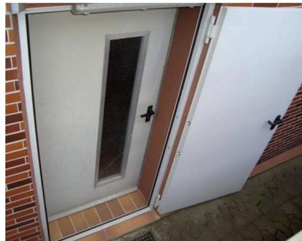
Zusätzliche wasser- und druckdichte Außentür (Quelle [9])
