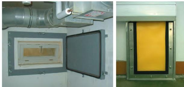
Druckdichtes Fenster (links) und spezielle Folienabdichtung (rechts) (Quelle [5])
