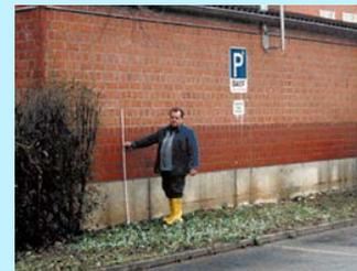
Abbildung 21: Durchfeuchtung des Mauerwerks (Gewässerdirektion Neckar, 2001)
