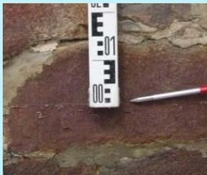
Abbildung 20: Schmutzwasserkante (LfULG, 2015)
