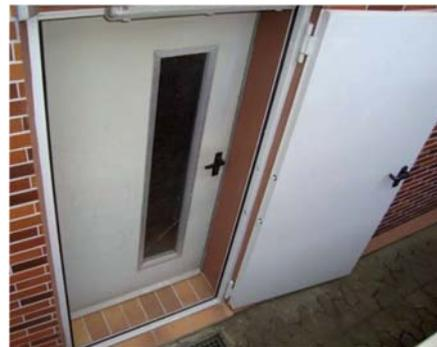
Zusätzliche wasser- und druckdichte Außentür (Quelle [5])
