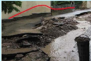
Abbildung 20: Durchfeuchtung des Mauerwerks (mit Welle aufgrund einer Bodenschanze auf der Straße) (IÖR, 2018)
